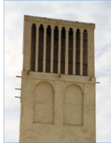
Figure 93 : Cage et colonne d'un Badgir
