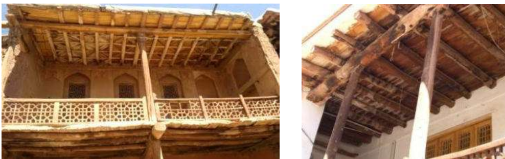
Figure 161 : Balcons et terrasses d'Abyaneh
