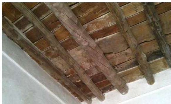
Figure 39 : Poutres en bois utilisés pour la construction des maisons et des Badgirs
