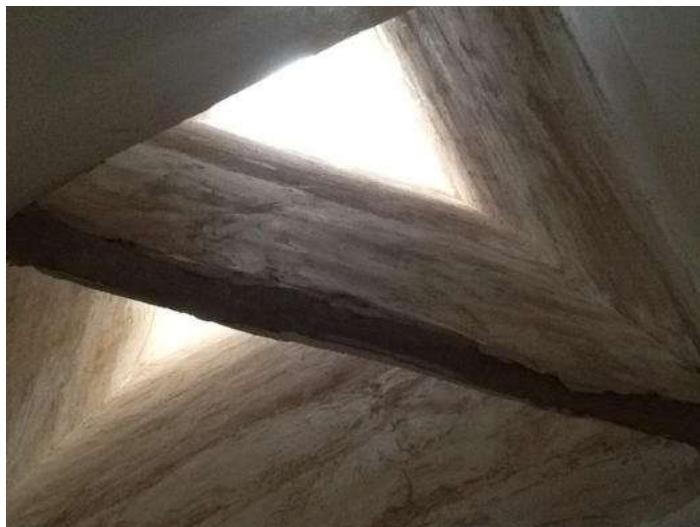
Figure 212 : Lames et conduits du Badgir de Siraf
