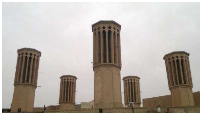
Figure 42 : 5 Badgirs couvrant un réservoir d'eau, Yazd
