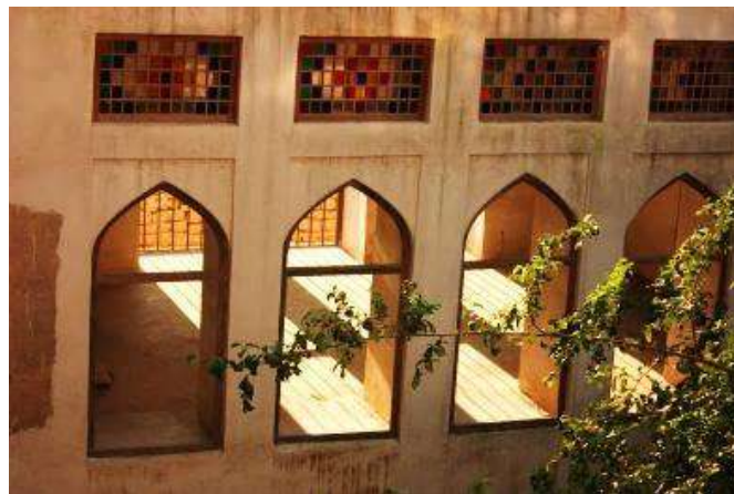
Figure 151 : Grandes et larges ouvertures à Bushehr
