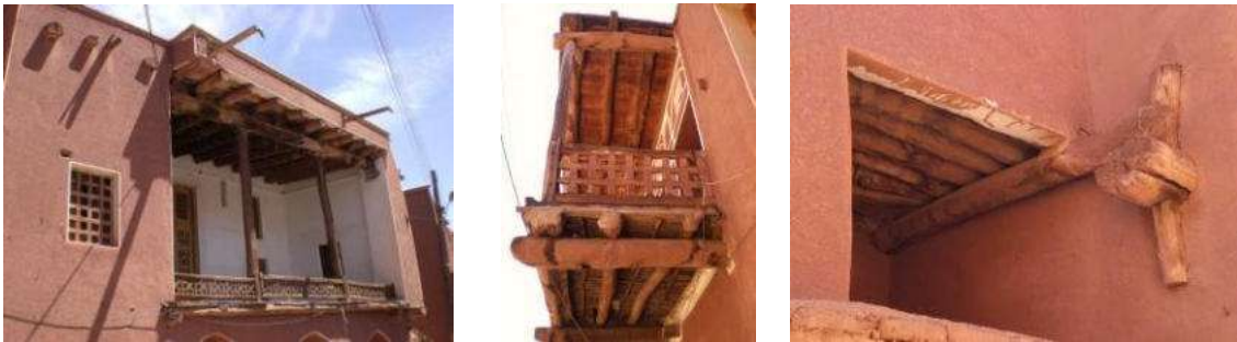
Figure 163 : Structure des maisons à Abyaneh (terre, bois, pierre)
