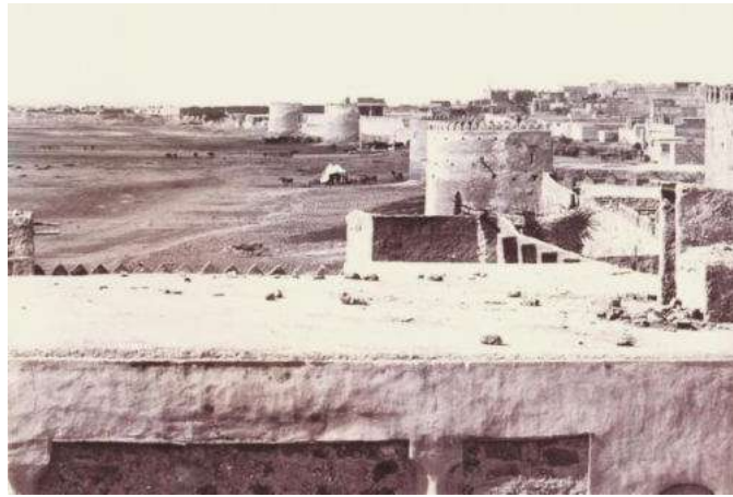
Figure 149 : Les tours de protection de la ville, construites il y a plusieurs siècles ; disparues à ce jour (source : bureau de l'urbanisme de la ville de Bushehr)
