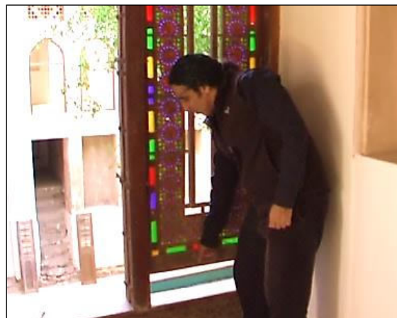
Figure 67 : Fenêtre construite en plusieurs parties distinctes
